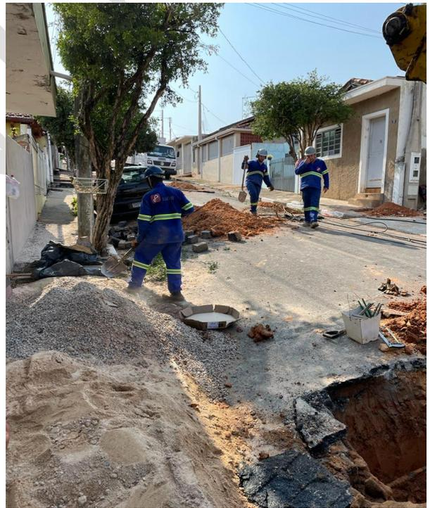
**Figura TEC 3** – Substituição pelo Método Não Destrutivo (MND) das Redes de Distribuição de Água e Ramais de Ligação dos Bairros Vila Macedo, Corcovado e Vila Santo Antônio. Fonte: SAAE
